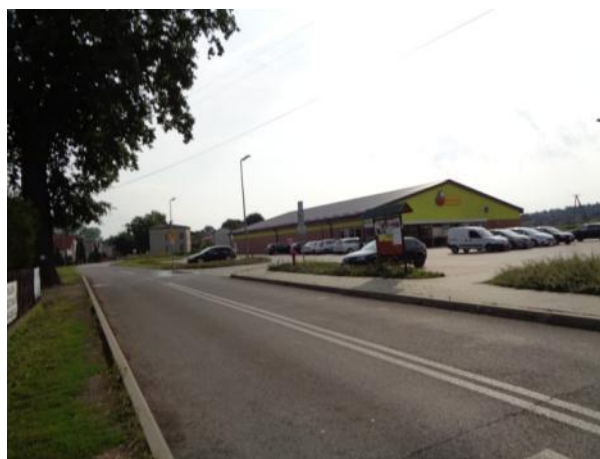
SKLEP "BIEDRONKA" PRZY UL. OŁTUSZEWSKIEGO
