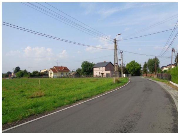
ZABUDOWA W REJONIE UL. WRÓBLEWSKIEGO
