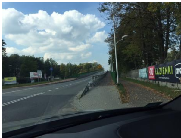
WIADUKT UL. CENTRALNEJ NAD LINIĄ KOLEJOWĄ
