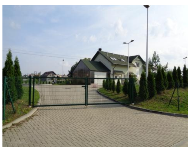
BUDYNEK OCZYSZCZALNI ŚCIEKÓW
