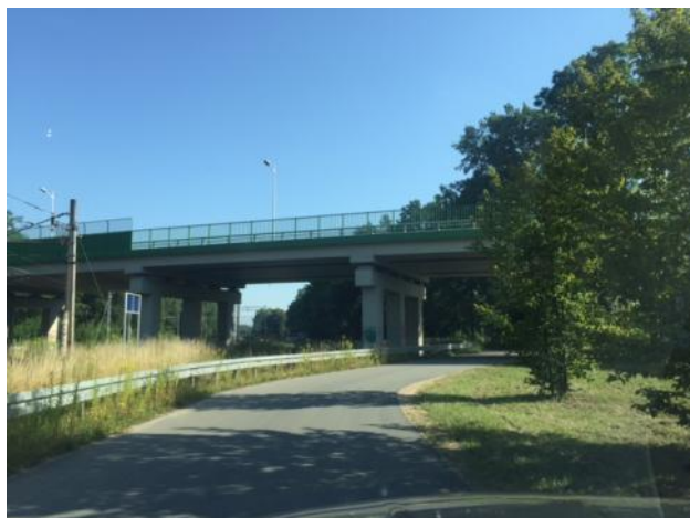
DOJAZD DO STACJI KOLEJOWEJ POD WIADUKTEM UL. CENTRALNEJ NAD LINIĄ KOLEJOWĄ
