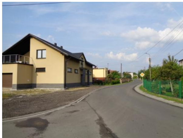
ZABUDOWA W REJONIE UL. WRÓBLEWSKIEGO
